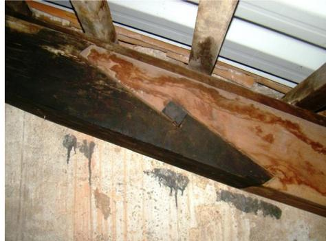
Fig. 06 – Asna de tesoura encachorrada com mão-de-amigo. Telhado da nave da Basílica da Penha do Recife – PE.
